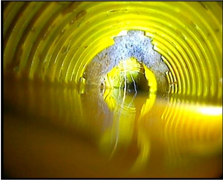
Şekil 4.4 Basıncılı su ile temizlemenin boru eklerine verdiği zarar
